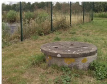
Le puits n°1
